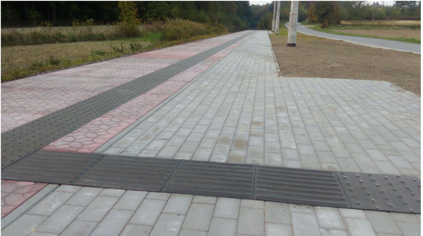
Przykład zastosowania płytek kierunkowych i ostrzegawczych na stacji kolejowej. Województwo Lubelskie.
