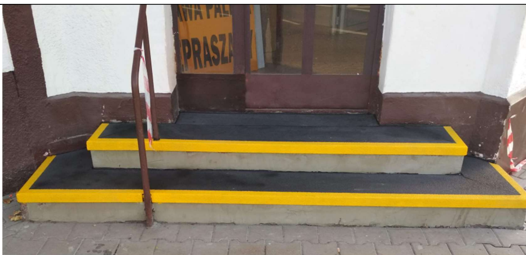
Stopnie schodowe zabezpieczone na całej głębokości. Dzięki takiemu rozwiązaniu stare zniszczone schody betonowe dostały nowe życie bez drogich remontów.
